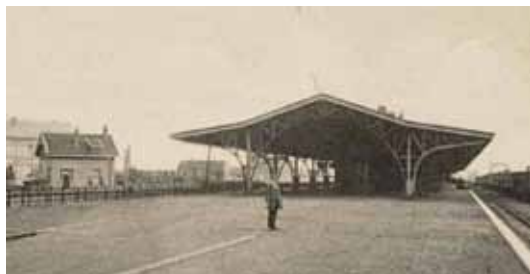
De overkapping aan de Nederlandse zijde van het grensstation. Na WO-I hadden de streekbussen hier hun halte.
