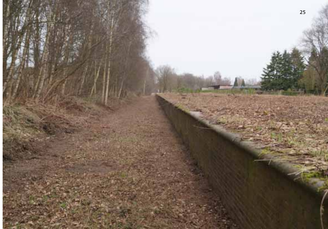
Aan de westzijde van het perron is een voetpad aangelegd. (foto's collectie Heemkundekring Amalia van Solms Baarle-Hertog/Nassau)
