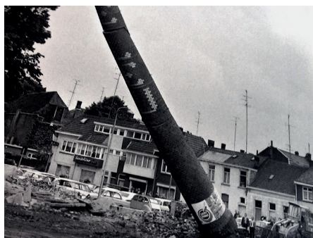
Tuinstraat 1962: sloop van de schoorsteen Gebroeders Van Spaendonck
